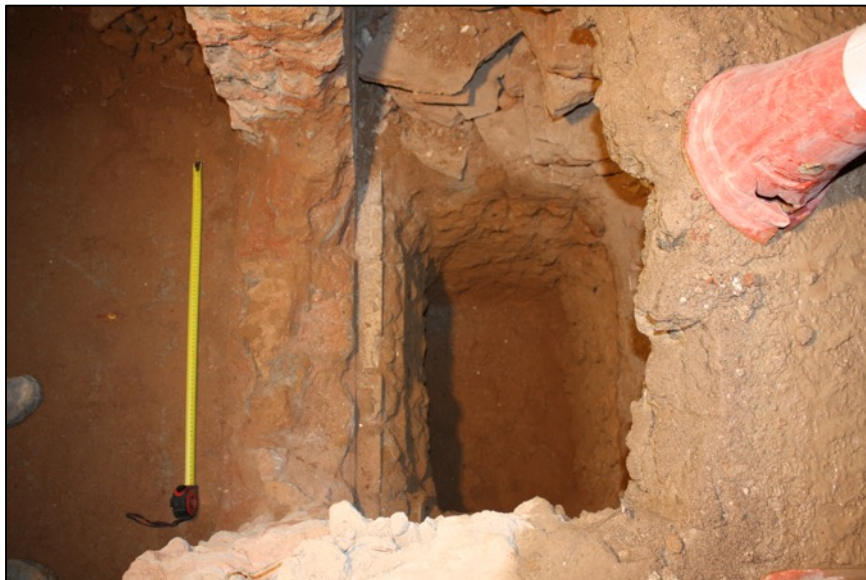
Fotografia 7. Final obertura cala de fonamentació.
