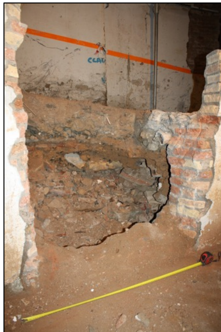
Fotografia 2. Estratigrafia rampa pàrquing amb llosa de formigó UE100 i nivell de runa UE101.
