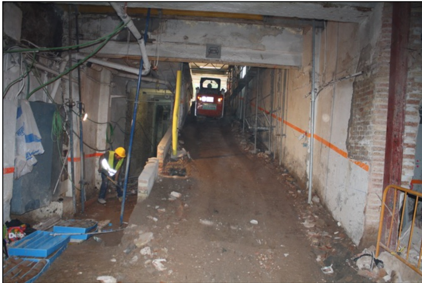
Fotografia 1. Rampa d'accés al pàrquing de la finca Bot 21.
